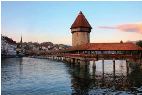
图2 卢塞恩的卡佩尔廊桥
