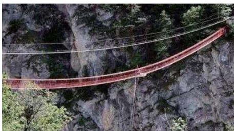
图4 尼欧克大桥照片
