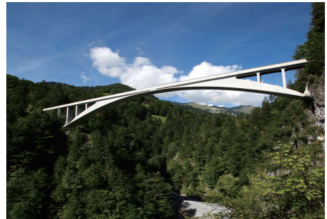
图7 萨尔基那山谷桥照片
