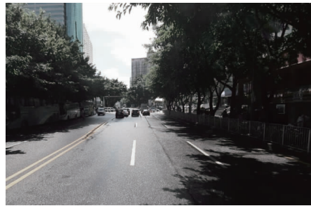
图 1 原解放路交通运行实景
