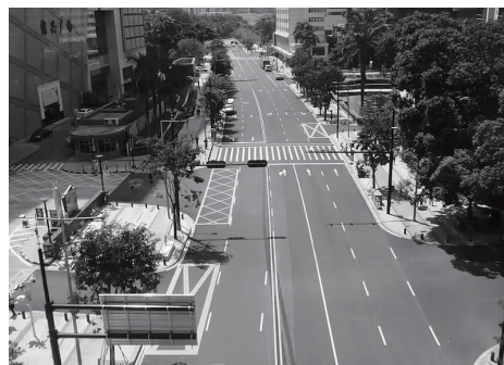
图 3 解放路改造后航拍实景
