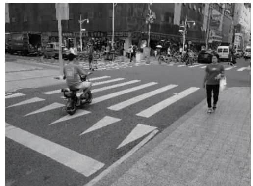
图10 交叉口抬升实景
