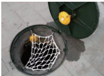
图3 井盖监测传感器和液位监测传感器
