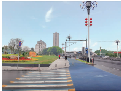
图7 非机动车道连续铺装
