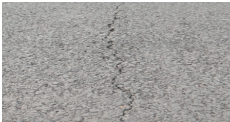
图2 路面裂缝
