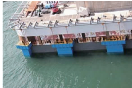
图5 浪溅区、潮差区涂装修复设置“干燥箱”示意图
