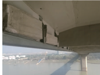
图6 π形梁现场底部示意图
