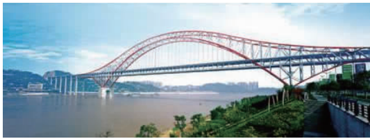
图1 重庆朝天门长江大桥
