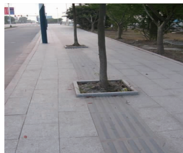
图2 树池侵占盲道
