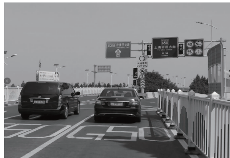
图 16 竣工通车照片二
