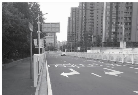
图 15 竣工通车照片一
