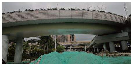
图 12 S101#~S100# 墩主桥跨中位置成桥照片
