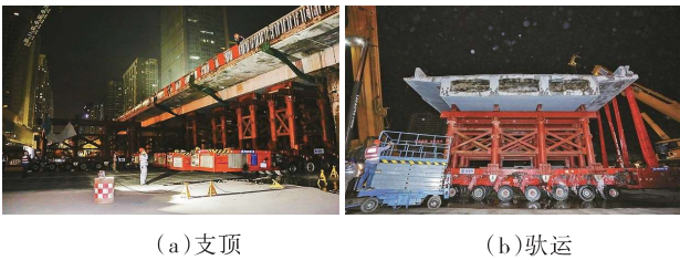
图2 模块车支顶切割驮运图示
