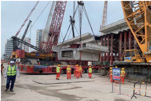
图3 履带吊吊装及模块车驮运
