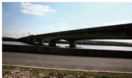
图1 待拆桥梁实景图
