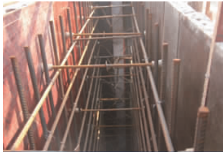
图3 组合式对拉螺杆安装示意图
