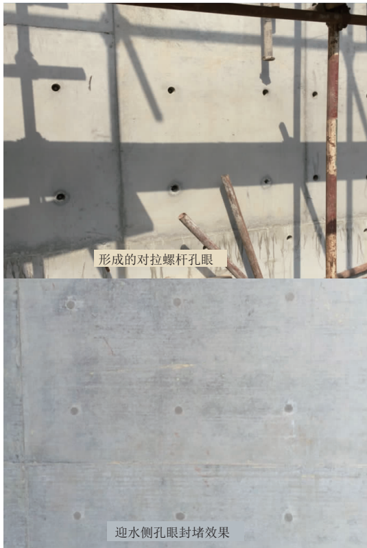
图4 孔眼封堵前后对比图
