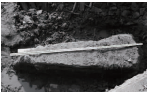
图 12 N-JET20 度摆喷在黏土层成桩半径达 3 m
