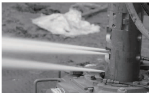
图 8 多喷嘴单侧喷射,适用于超大直径大深度快速加固施工、深基坑底深层止水加固,各种角度复杂地形组合施工
