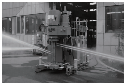
图 5 双喷嘴对称倾斜喷射、适合卵石层、漂石层施工
