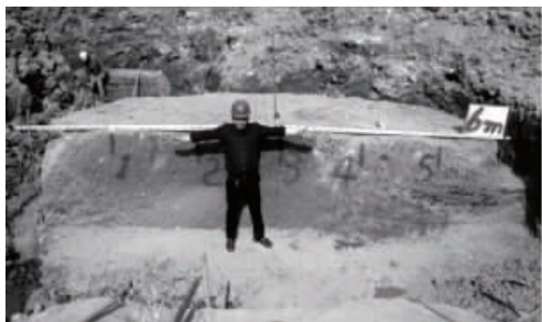
图 11 上海黏土层喷射直径达 6 m 180°摆喷成桩质量开挖,水泥土喷射搅拌均匀。
