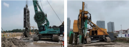
(a)成槽机引孔 (b)TRD 施工
