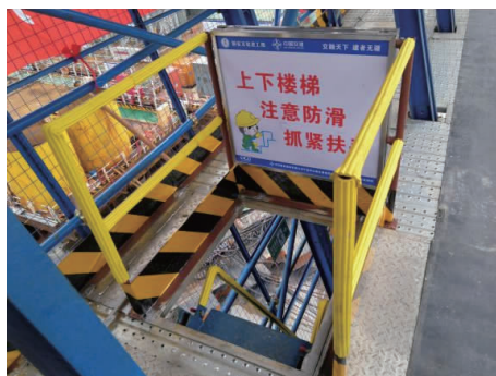
图 7 通道口采取的软保护措施
