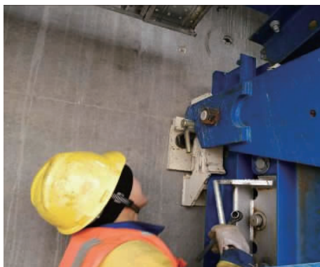
图 3 爬模爬升到位后插入保险销
