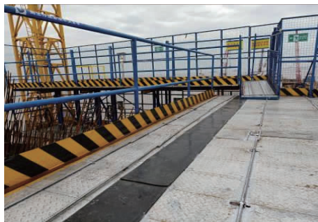
图 5 钢筋绑扎平台顶层设置插入式护栏
