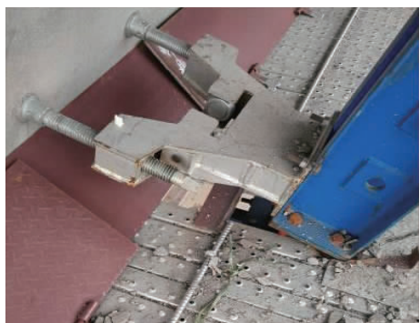
图 4 架体防倾调节支腿顶撑混凝土
