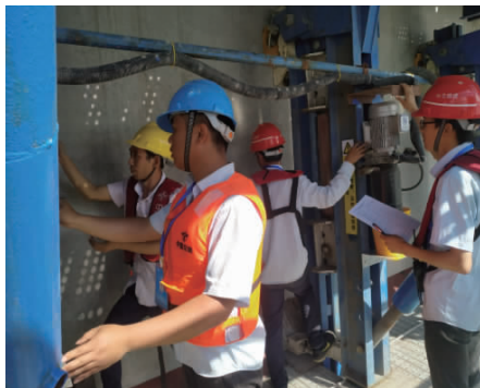
图 2 组织液压爬模爬升前检查
