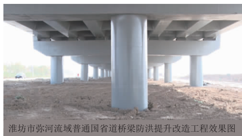
图 1 潍坊市弥河流域普通国省道桥梁防洪提升改造工程涂装后照片
