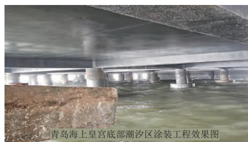
图 2 青岛海上皇宫底部潮汐区涂装工程照片
