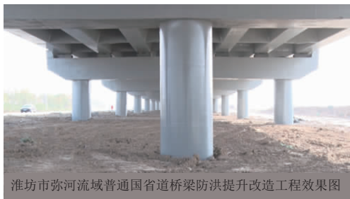
图1 潍坊市弥河流域普通国道桥梁防洪提升改造工程涂装后照片
