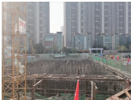
图 8 泵房施工现场
