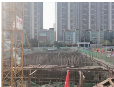
图 8 泵房施工现场
