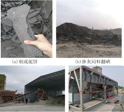
(a)制成泥饼 (b)掺灰闷料翻晒 (c)破碎 (d)掺灰拌和
