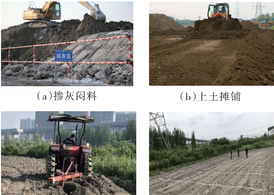
图3 淤泥质土路拌工艺主要流程
