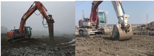
图2 软土就地固化施工过程
