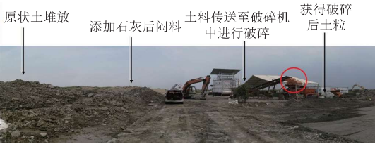
图4 淤泥质土厂拌工艺主要流程
