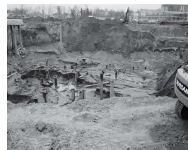
(a)吹砂管与泥浆泵 (b)基坑内水冲设备与挖机协同工作
