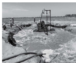
(a)吹砂管与泥浆泵 (b)基坑内水冲设备与挖机协同工作
