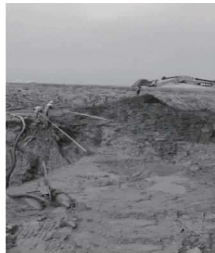
图6 水冲法中的翻土冲挖法
