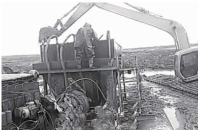
图5 水冲法中的挖机喂斗法
