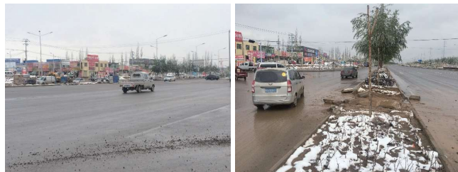
图1 交叉口现状情况
