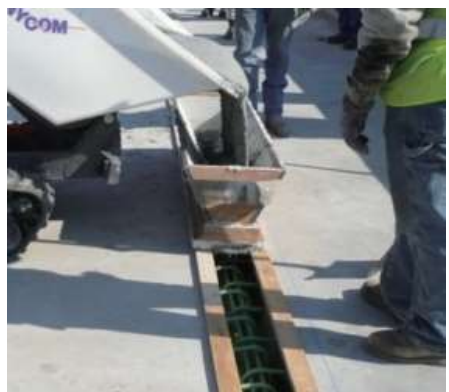
图3 环形钢筋交错布置湿接缝连接之实景
