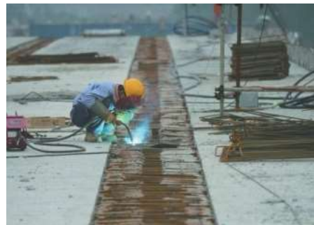
图2 传统桥面湿接缝焊接连接之实景
