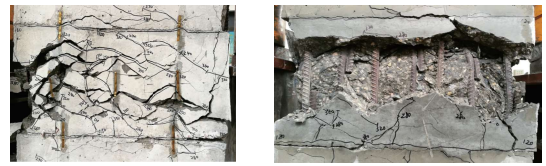
图10 HPC-J3试件破坏时刻开裂状态图示
