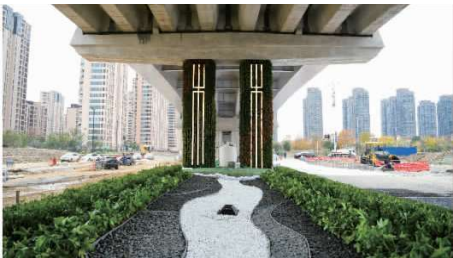
图 3 工程应用实景
