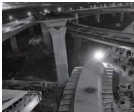
图4 曲线桥落梁
