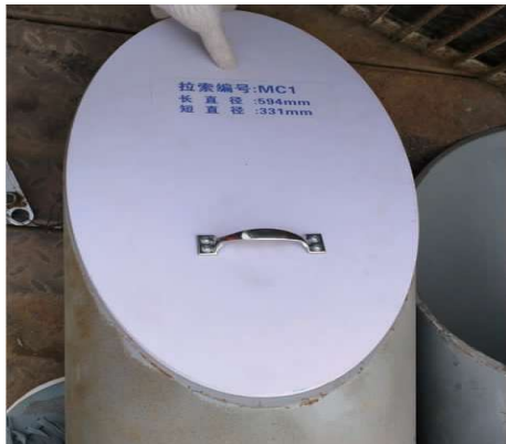
图5 出塔点中心定位器之实景
