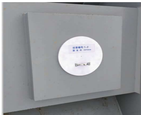
图4 锚固点中心定位器之实景
