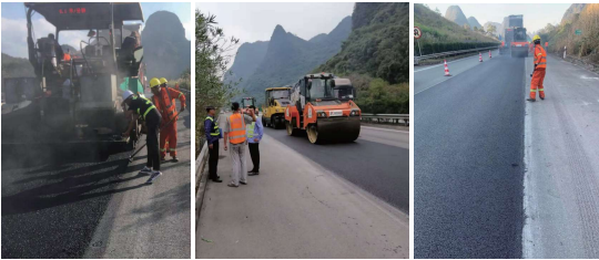
图 2 摊铺与压实之实景
