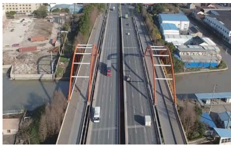
图 12 浦东运河现状桥梁实景图
