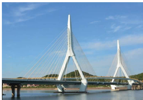
图 10 绵阳三江大桥实景图
