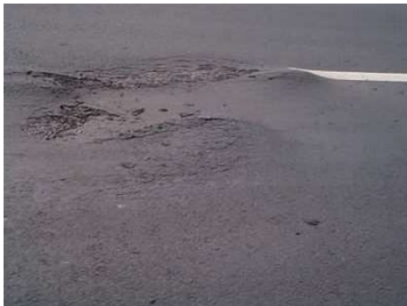
图3 路面推移、拥包病害示意图
