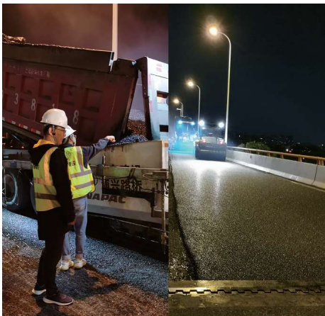
图 5 OGFC-13 铺装施工
