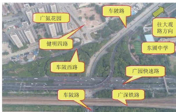
图2 广园立交节点现状航拍图
