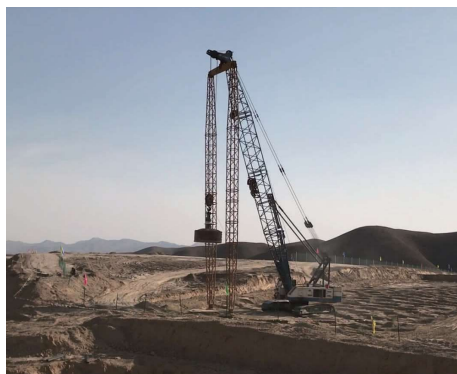
图 3 现场强夯施工照片之实景
