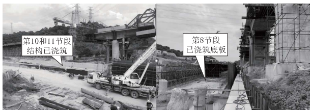
图14 隧道结构现场施工照片
