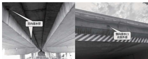
图16 北二环高速排水孔
