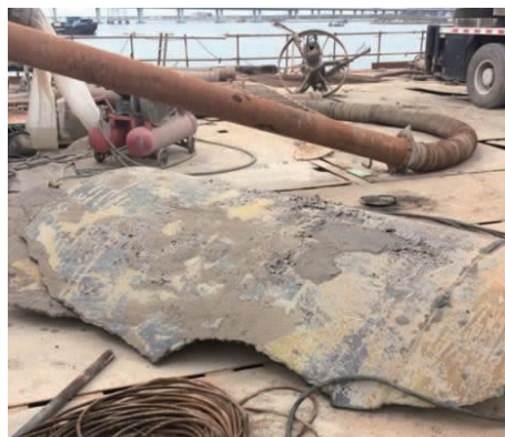
图4 钢护筒底口割除
