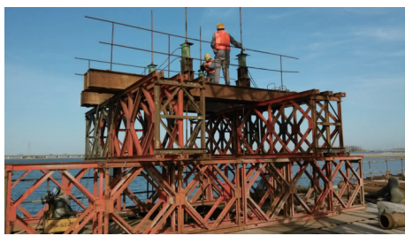
图2 钢护筒拔出施工
