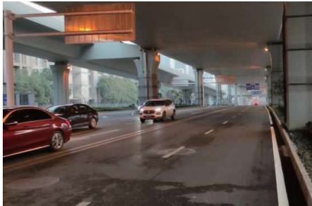
图 3 高架桥下凹曲线半径偏小
