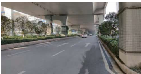
图4 平面交叉口三角区视距不足
