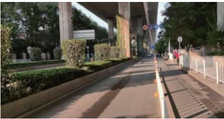
图 2 高架桥桥墩不合理布设
