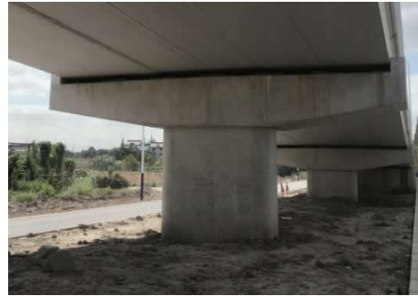
图4 单柱墩实景图
