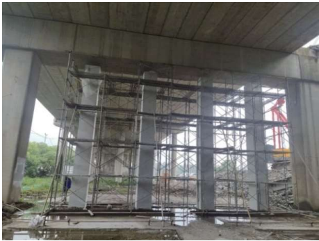
图15 盖梁加固现场图
