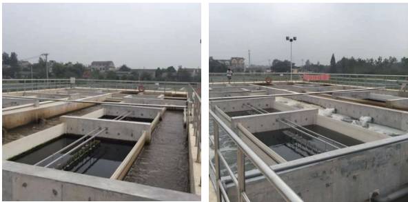
图 4 VFL 工艺再生水厂现场之实景
