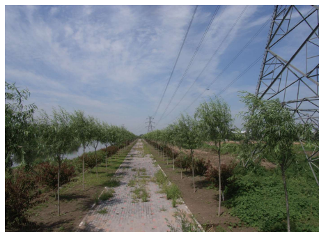
图5 现状高压走廊
