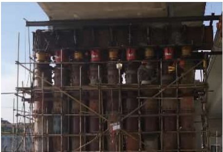
图 3 主墩顶升施工
