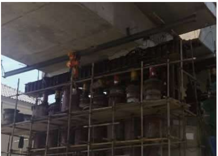
图 5 边墩顶升施工
