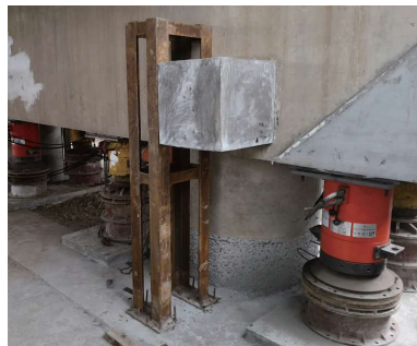
图 11 桥墩限位柱之实景
