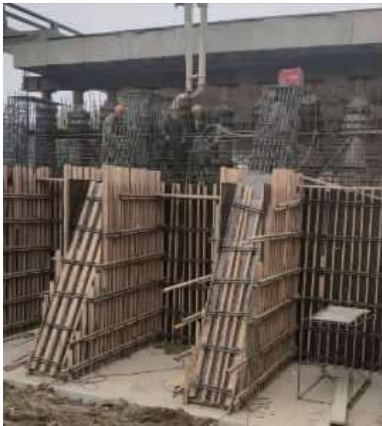
图 23 台后扶壁浇筑之实景
