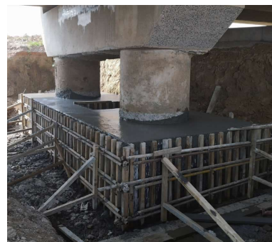
图6 抱柱梁浇筑之实景
