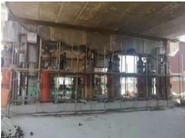
图 19 4 号墩顶升之实景
