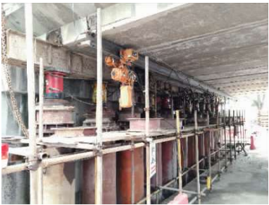
图 22 6 号台顶升之实景
