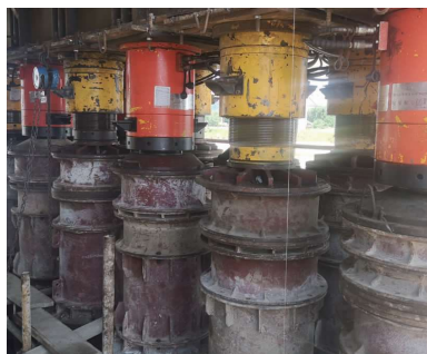
图 7 千斤顶和支撑钢管之实景
