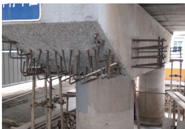
图 9 盖梁三角垫块施工之实景
