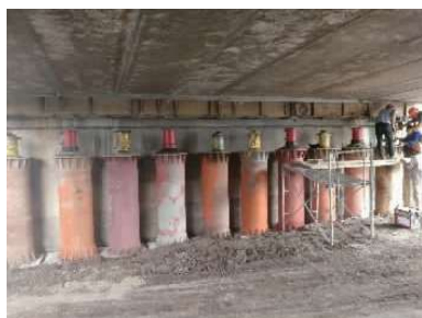
图 10 桥台钢分配梁之实景
