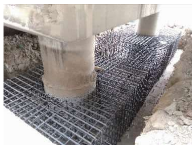
图5 抱柱梁钢筋绑扎之实景
