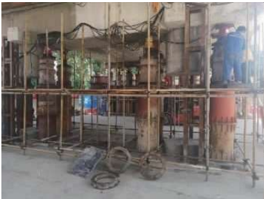
图 20 5 号墩顶升之实景
