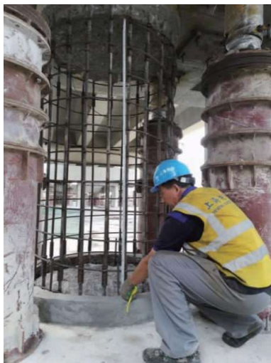
图 14 立柱连接施工之实景
