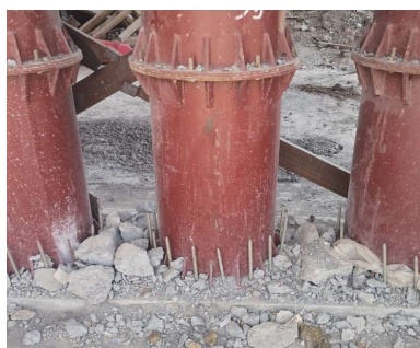
图 8 支撑钢管之实景
