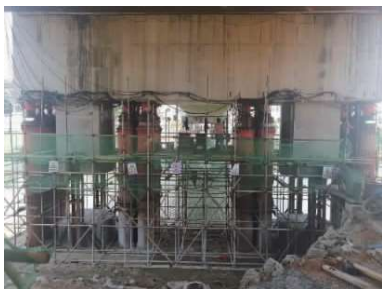
图 15 主墩顶升施工之实景
