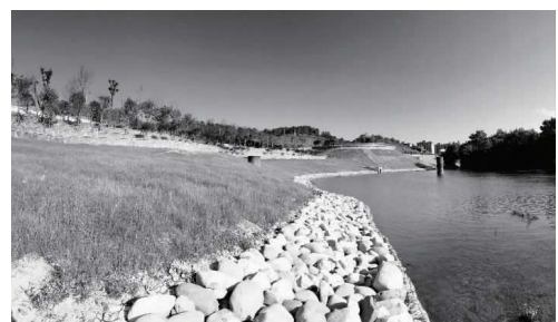
图3 堤防断面建成实景
