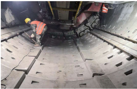
图5 型钢拉结固定管片
