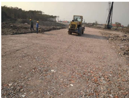
图 3 建筑碎石分层碾压展示图
