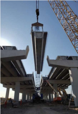
(b) 路基应用于吊装施工
