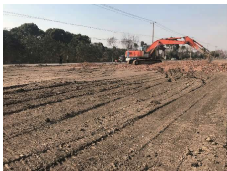
图 2 建筑碎石铺摊展示图
