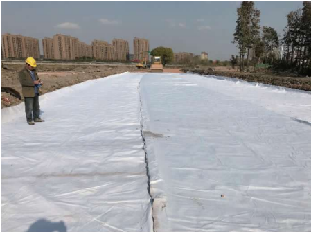
(b) 土工布施工
