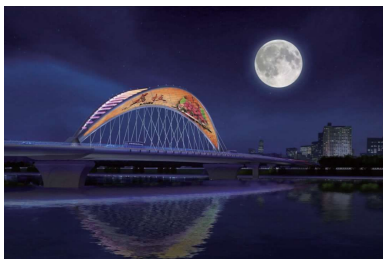
图 1 从化大桥实景图
