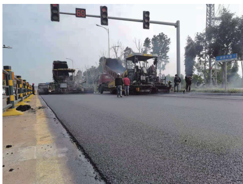
图4 超薄罩面摊铺
