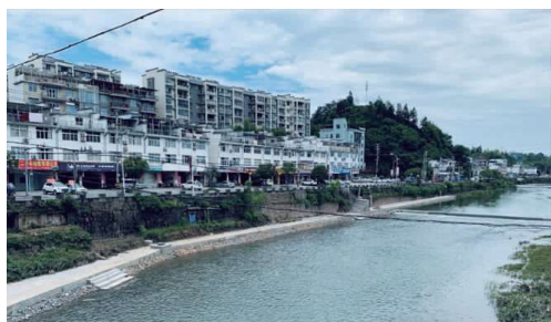
图 10 火车站桥至加油栈桥段实景
